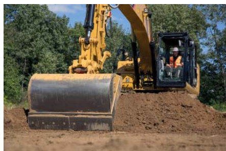
Mit der neuen Maschinensteuerung gelingt ein hochgenaues Planum einhändig und im Nu. (Foto: Caterpillar/Zeppelin)
