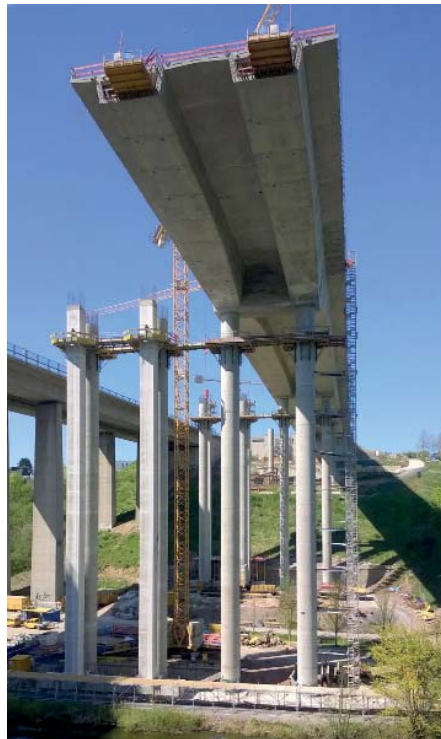
Die Überbauten der 450 m langen Balkenbrücke aus gevouteten zweizelligen Spannbetonhohlkästen entstehen im Freivorbau.
