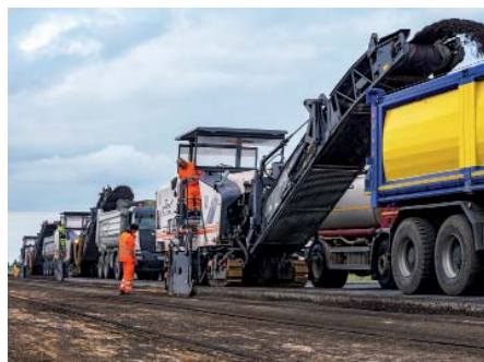
Am Start- und Landebahnkopf mussten die Unterschichten stabilisiert werden. Das Wirtgen-Trio baute 3.420 m 3 Material aus.
