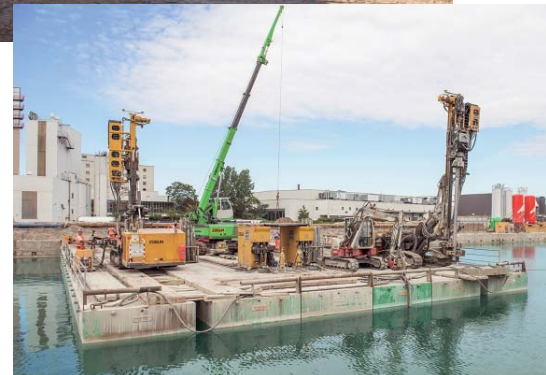
Umfangreiche Arbeiten sind unter Wasser mit Geräten, die auf Pontons stehen, auszuführen.
