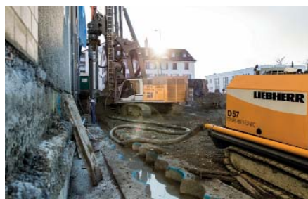
Multifunktional: Mit dem LRB 355 setzt Hilti & Jehle das neueste Ramm- und Bohrgerät aus dem Hause Liebherr ein.
