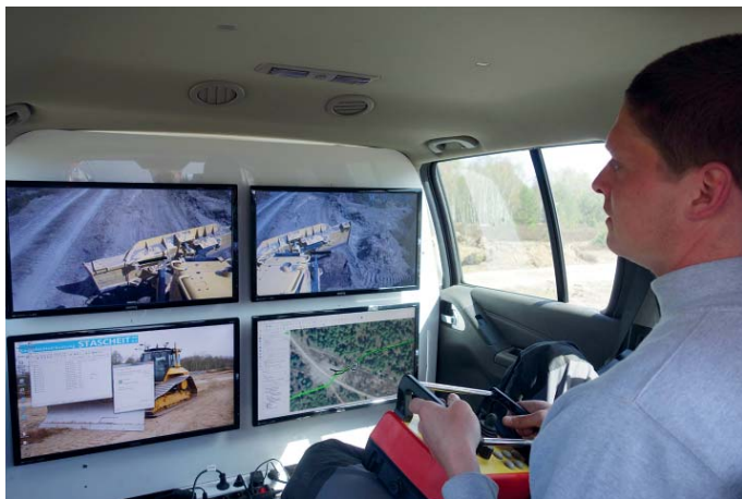
Im Begleitfahrzeug steuern Tobias Schulze und Maik Bothe im Wechsel die Baumaschine, quasi wie von einer Computerkonsole aus.
