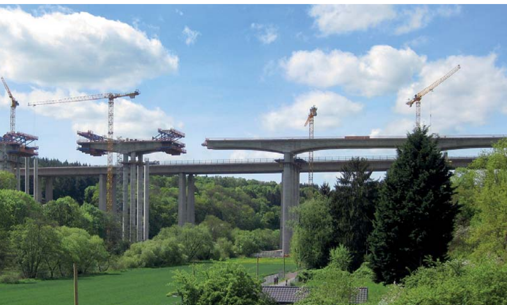
Wenige Meter östlich der alten Lahntalbrücke entsteht bei Limburg bis Ende 2016 ein neuer Flussübergang im Zuge der Autobahn A3. (Fotos: Doka)
