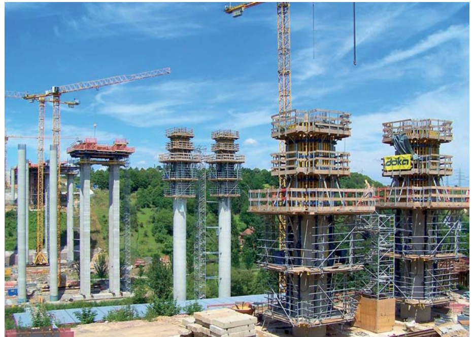
Jeweils paarweise angeordnete superschlanke Stahlbetonrundstützen tragen den Überbau. Ihr Durchmesser beträgt maximal 2,80 m bei einer Pfeilerhöhe bis zu 57,0 m.
