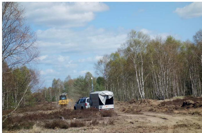
Im Einsatz hält das Begleitfahrzeug rund 1000 m Sicherheitsabstand zum ferngesteuerten Dozer.
