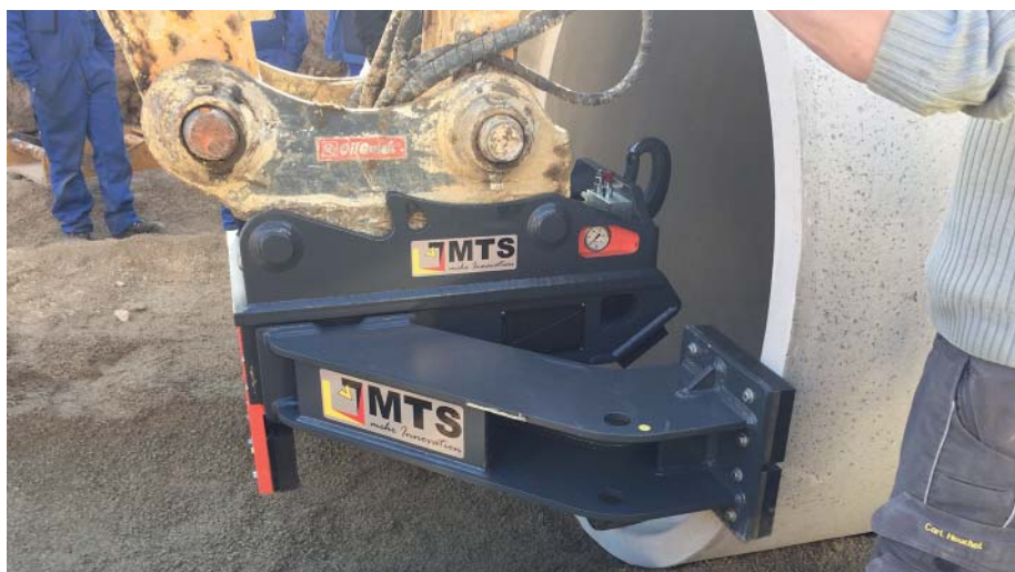
Der um beidseitige Seitenarme erweiterte Rohrschiebeadapter schaffte es, auch die groen Rohre normgerecht zu fgen. (Fotos: MTS)
