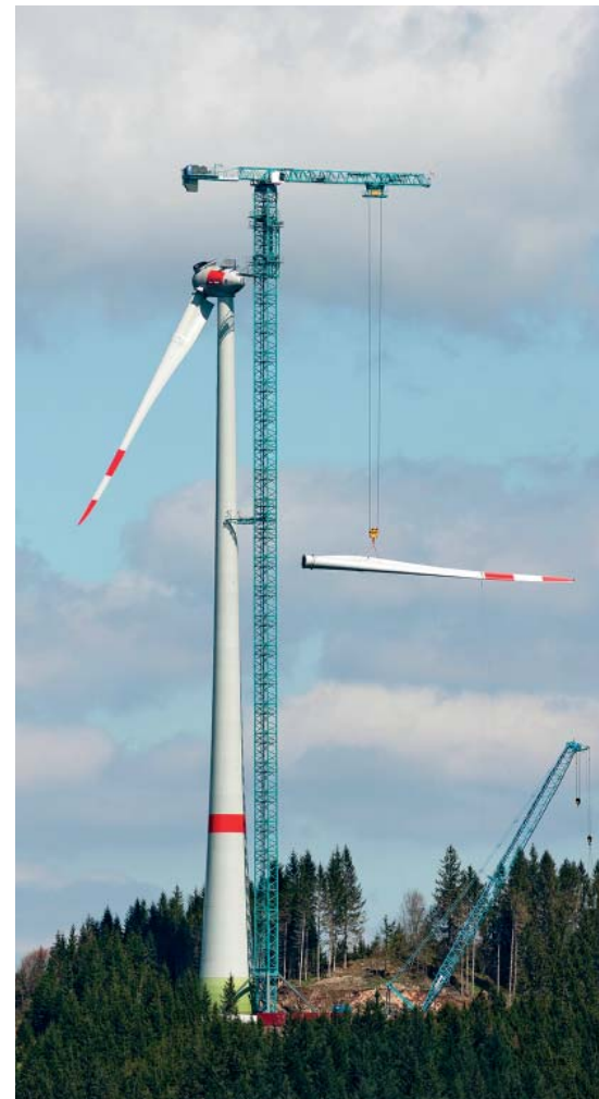
Endhakenhöhe 164 m: Der Turmdrehkran 1000 EC-B 125 Litronic bei der Montage der Windkraftanlage im Schwarzwald. (Fotos: Liebherr)
