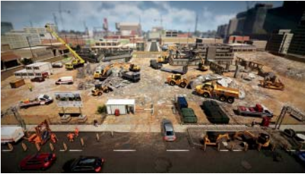
Lösungen zum Schwerpunktthema Digitalisierung sollen die komplette Baustellenabwicklung ökonomischer und ökologischer gestalten. (Foto: Zeppelin)
