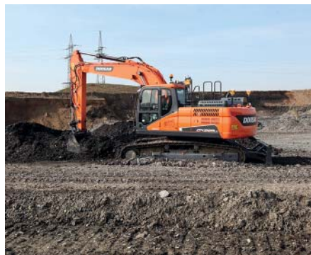
Der Doosan DX225LC-5 wird als Trimble Ready-Bagger für die vereinfachte Installation der Trimble-Maschinensteuerung vorbereitet. (Foto: Doosan Infracore)
