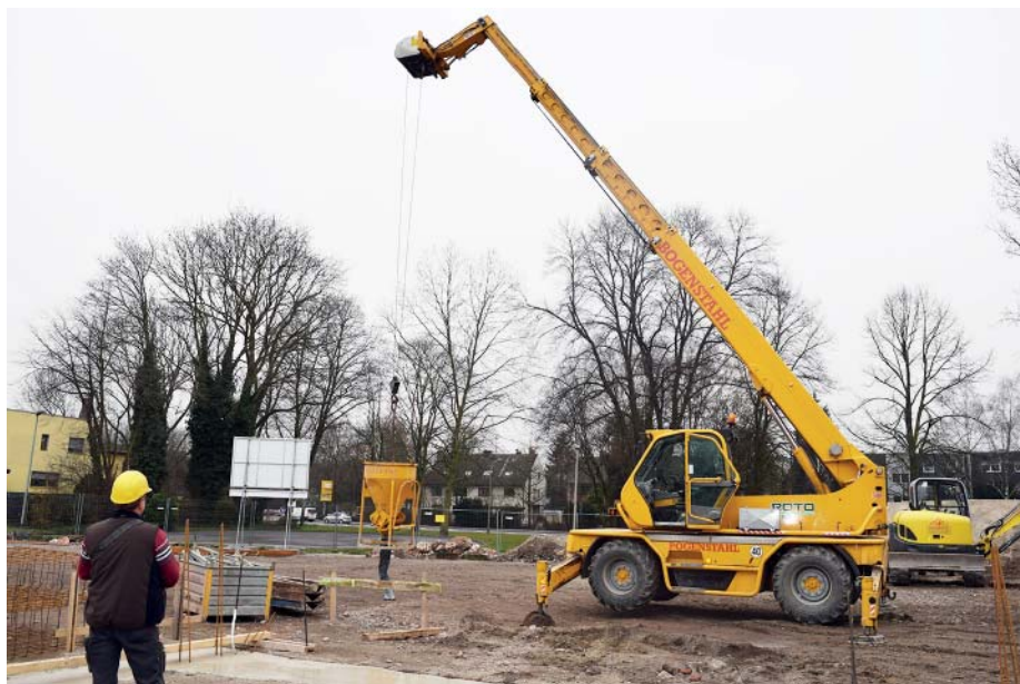
Kranbetrieb: Per Funkfernsteuerung kann ein Mann außerhalb der Maschine Arm und Oberwagen am Roto exakt zur Platzierung der Betonbombe einstellen.
