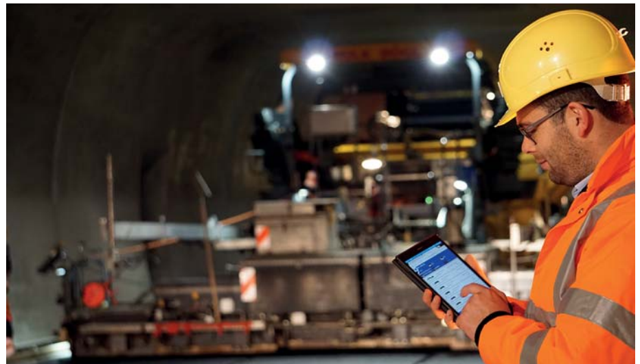
Zur Optimierung des Asphalteinbaus im Scheibengipfeltunnel in der Region Reutlingen setzte Max Bögl das System BPO von Volz Consulting ein.
