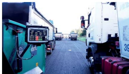
Die PxKonsole am Asphalt-Fertiger beim Einbau „Heiß-an-Heiß“. Bis zu drei Fertiger können mit dem System kommunizieren und über W-LAN geortet werden. (Foto: Praxis EDV)
