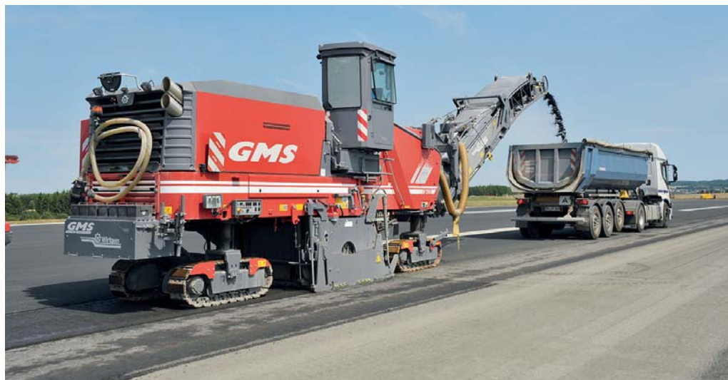
Die Kabine der Großfräsen lässt sich rechts wie links über die Nullkante hinausbewegen und sorgt für beste Sicht auf das Geschehen. (Fotos: Wirtgen Group)
