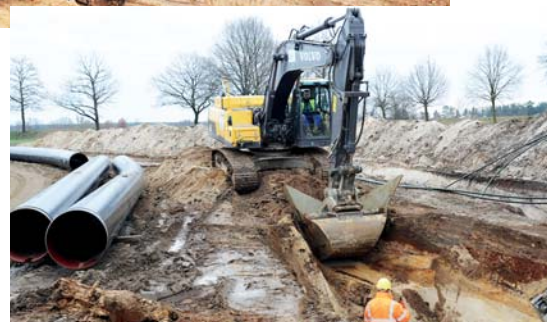
Den profilierten Rohrgraben zieht der Raupenbagger EC250D mit einer Spezialschaufel in Windeseile.
