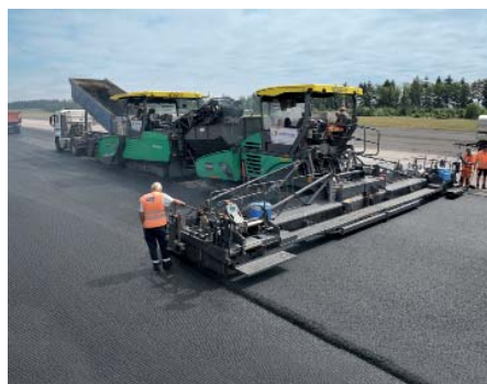
Für den Einbau der neuen Asphaltdeckschicht brachte Generalunternehmer Juchem Asphaltbau zwei leistungsstarke Vögele-Fertiger mit nach Büchel.
