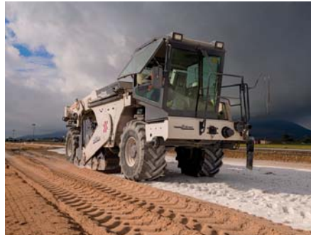
Bodenstabilisierer durchmischen den tonhaltigen Boden mit Kalk und Zement, um die gewünschte Tragfähigkeit zu erzielen.
