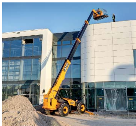
17 m Hubhöhe: Der niedrige Schwerpunkt und die stabilen Stützen des Teleskopladers garantieren optimale Standsicherheit. (Foto: JCB)
