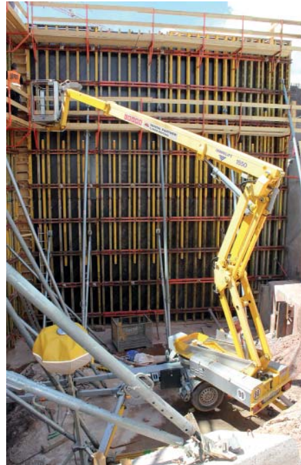
In der 20 m tiefen Baugrube konnte die Omme 1550 trotz enger Platzverhältnisse ungehindert eingesetzt werden. (Foto: Cramo)
