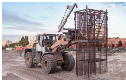
Eine spezielle Hubvorrichtung wurde für einen Radlader konstruiert, damit er den Bewehrungskorb beim Einheben und Einfädeln in den unteren Korb um alle Achsen drehen und kippen kann.
