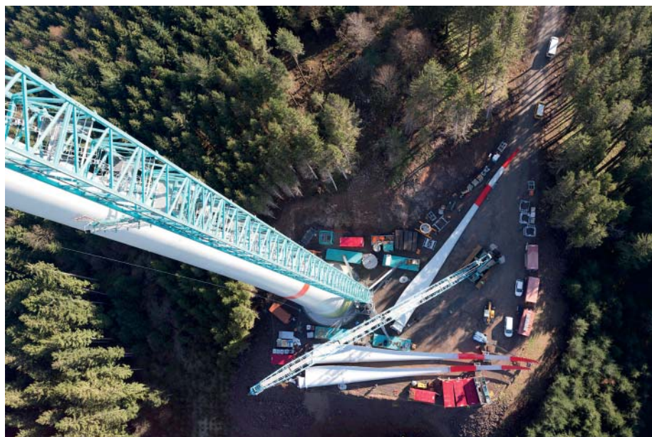
Der Flat-Top-Kran hat einen sehr geringen Platzbedarf.
