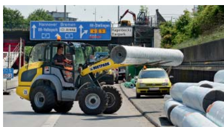
Ein Radlader aus dem Mietpark transportiert Rollen mit Geogitter über den Bauabschnitt auf der A7.
