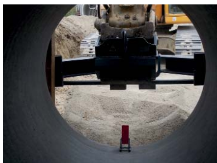
Die Seitenarme bringen die ntige Fgekraft an zwei seitlichen Punkten mittig auf das Rohr.
