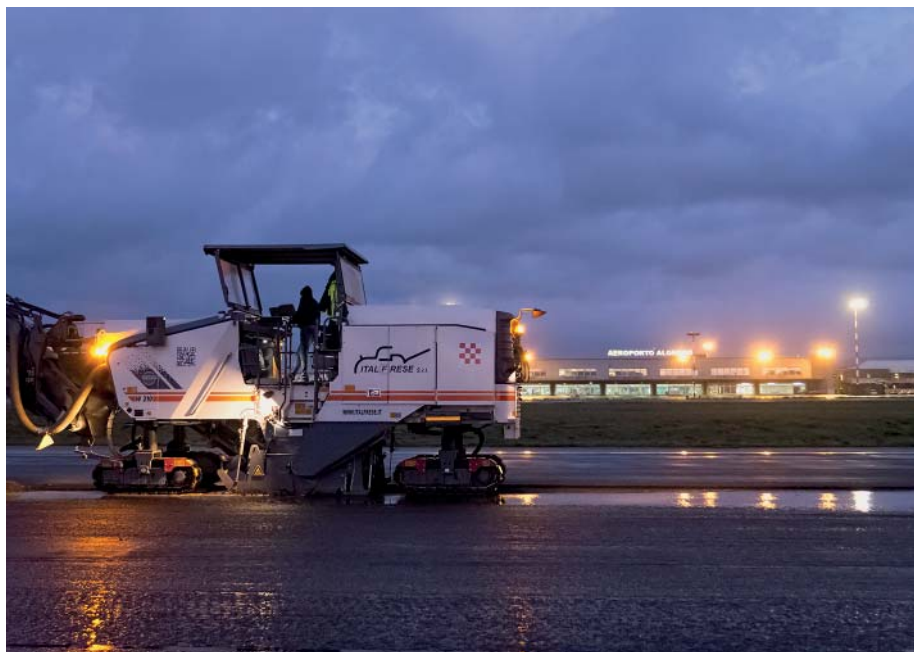
Nachtschicht am Flughafen: Auf 2,1 km entfernten Kaltfräsen den 5 cm dicken Asphaltbelag. (Fotos: Wirtgen)
