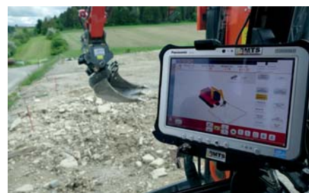
Neue Titrotatoren: Dank Sensortechnik kann der Geräteführer die Bewegungen des Löffels auf dem Display verfolgen. (Foto: MTS)
