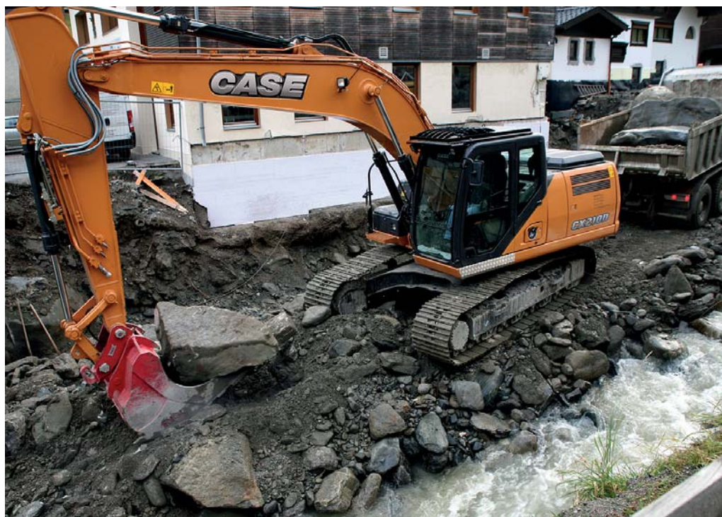
Der neue Bagger überzeugte im Wasserbau an der Melach durch schnelle Ladespiele bei geringem Verbrauch. (Foto: Case)
