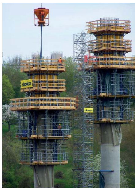
Die Schalung der runden Hauptpfeiler klettert mit der hydraulischen Selbstkletterschalung Xclimb 60. Das System ist ständig in Führungsschuhen am Bauwerk geführt.
