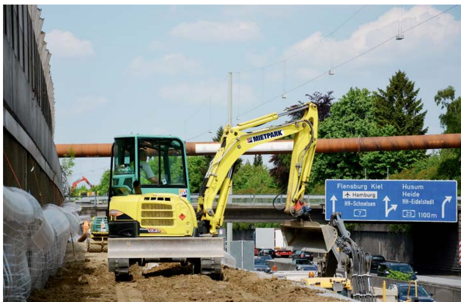
Ausbau A7: Ein Minibagger hilft beim Aufbau eines 4 m hohen Podestes am Fahrbahnrand. (Fotos: HKL)
