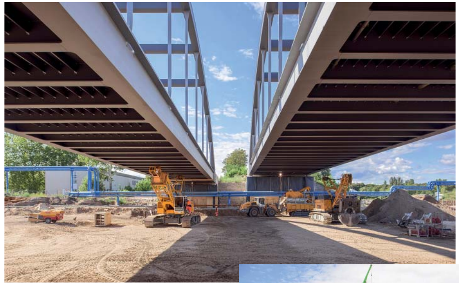
Begrenzter Raum: Eisenbahnbrücken schränken beim Ausbau des Berliner Autobahnring den Aktionsradius nach oben ein. (Fotos: Ed. Züblin)
