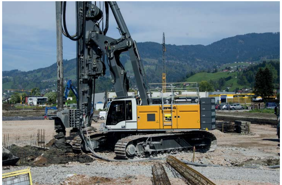
Premiere: Das Großdrehbohrgerät LB 44 von Liebherr auf einer Baustelle im österreichischen Dornbirn. (Fotos: Liebherr)
