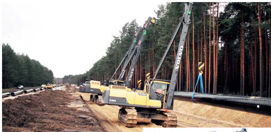
Mit vier modernen Rohrlegern rückte EAS ins Lausitzer Revier, um Gasleitungen ins Erdreich zu verlegen. (Fotos: Volvo CE)
