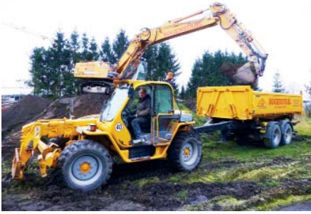
Zugmaschine: Der geländegängige Turbofarmer fährt den Bodenaushub beim Bau eines Regenrückhaltebeckens. ab. (Fotos: Merlo)
