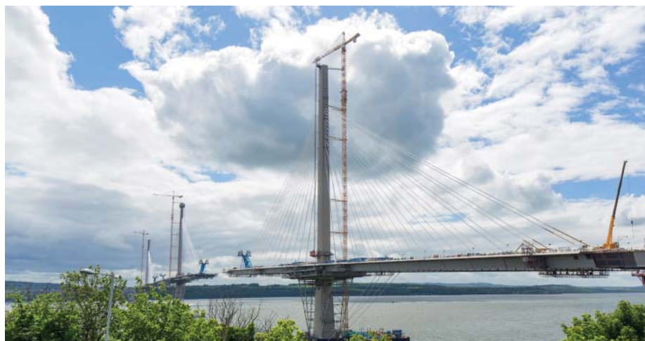
Schottisches Jahrhundertprojekt: Die 2,7 km lange Forth Crossing Bridge wird die weltweit längste Schrägseilbrücke mit drei Pylonen sein.
