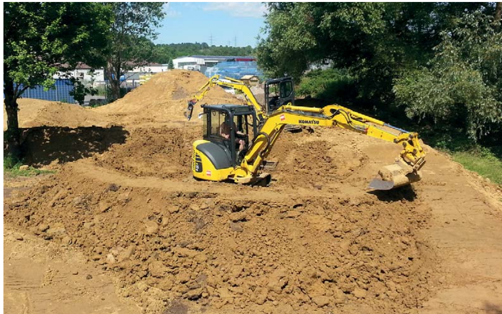
Feinfühligkeit gefragt: Beim Bau des Bikeparks kommt es sehr auf die Genauigkeit der Radien, Abstände und Höhen der Hügel und Hindernisse an. (Foto: Schlüter Baumaschinen)
